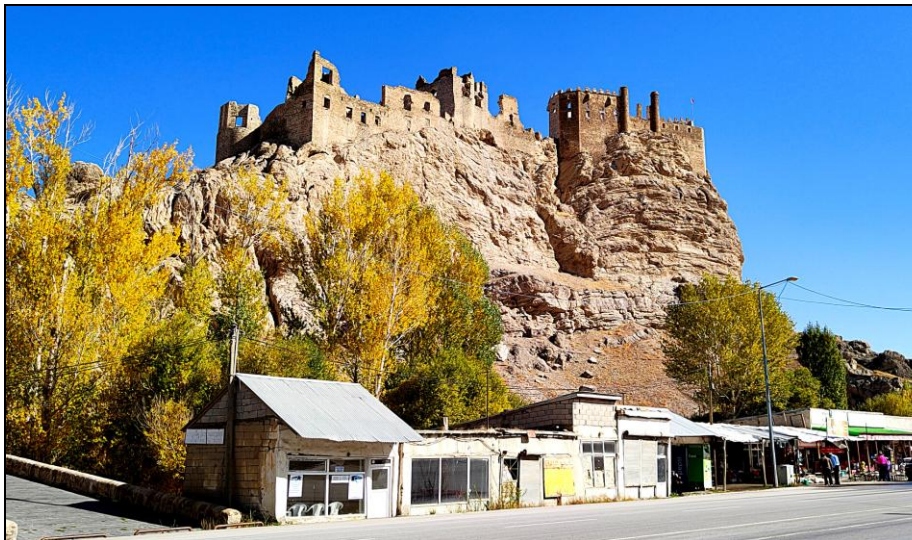
Fot. 47. Mury zamku na krawędzi stromej ściany skalnej (fot. W. Puczejda, 2023)
